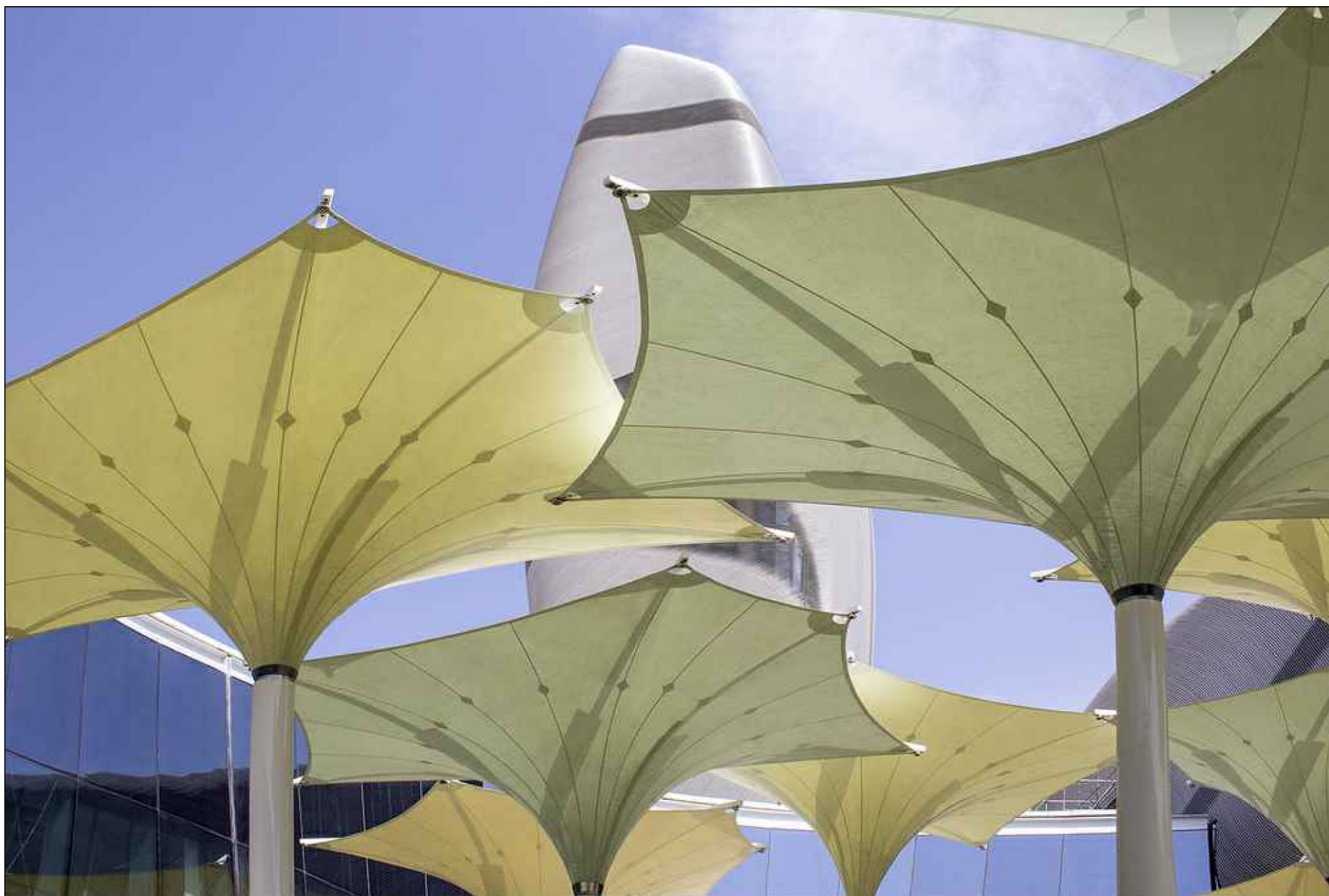
אלמנטי מתיחה על עמוד עבור שער הכניסה הדרומית תוצרת MED-TEX או ש"ע
